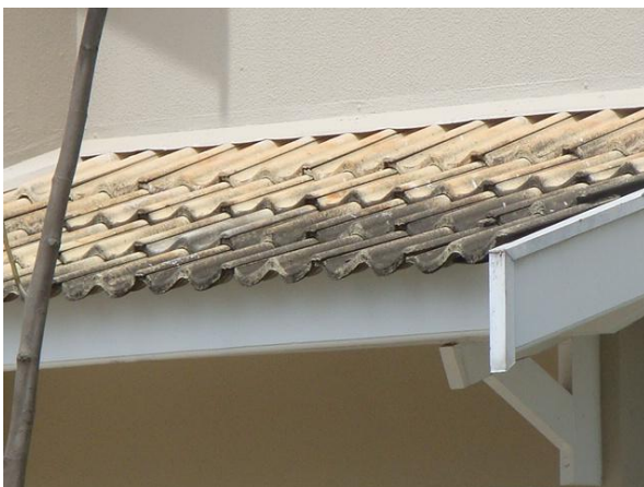
Telha de concreto: foto da direita, atacada por fungos (envelhecimento precoce), foto esquerda: "decompondo"
