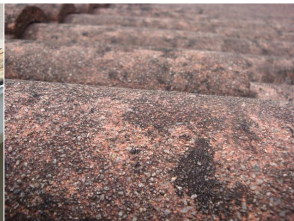
Telha de concreto: foto da direita, atacada por fungos (envelhecimento precoce), foto esquerda: "decompondo"
