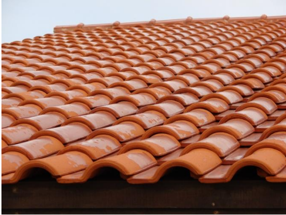
Telhas de barro "soltando" camada de "vidro".
