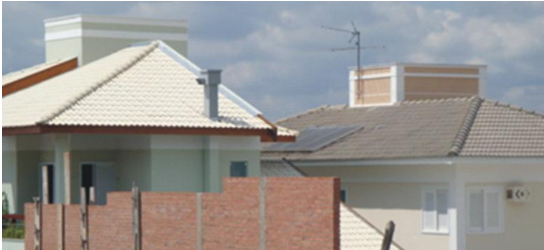
Casa com telha cerâmica ao lado casa com telha de concreto
